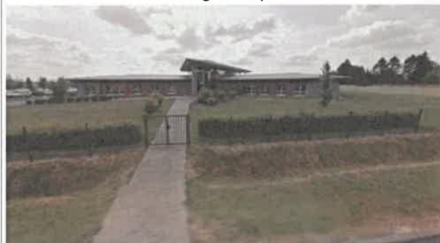
Vue Google Maps du bâti à partir de la RD 840
