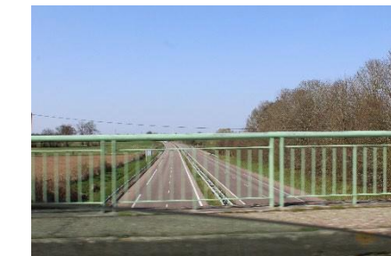
Autoroute A 131 Trouville la Haule
