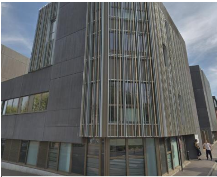
Maison de Justice et du Droit Louviers
