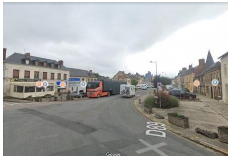
Entrée sud est Bourneville-Sainte-Croix (RD 89)
