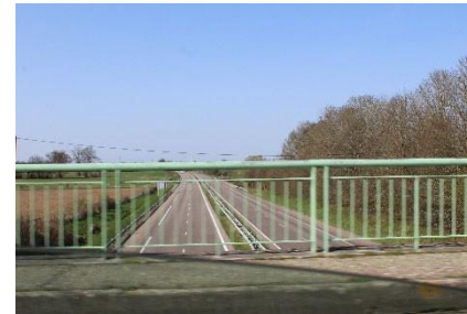
Autoroute A 131 Trouville la Haule
