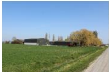
Structure agricole – vue depuis la RD 103 – commune de Saint-Aubin-sur-Quillebeuf
